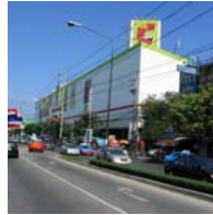
อาคารพาณิชย์กรรมค้าปลีกค้าส่ง \geq 300 ตร.ม.
